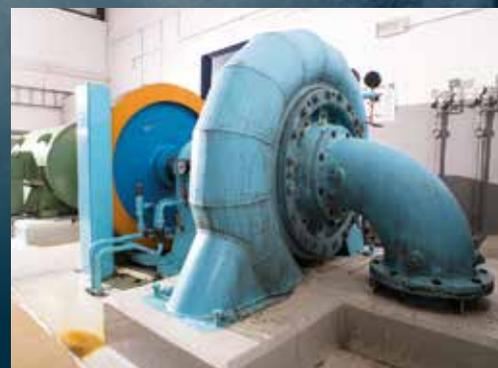
Das Maschinenhaus des Kraftwerks Sparchen von innen: Über die Francis-Turbine (blau) wird Strom erzeugt.
